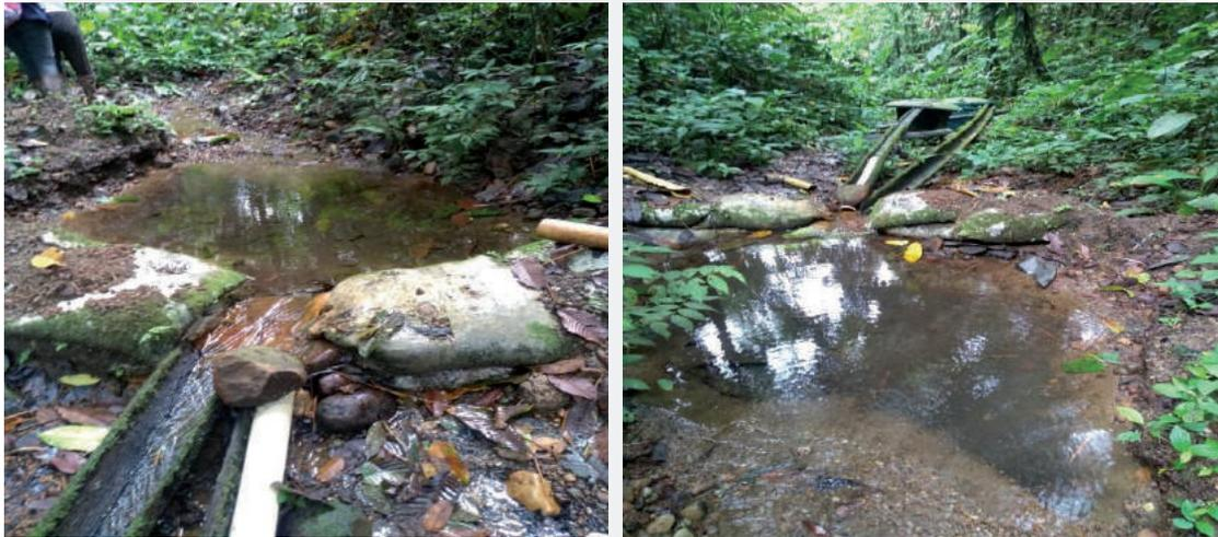
**Imagen 4.** Nacedero con represamiento artesanal y tubería de conducción para abastecimiento
