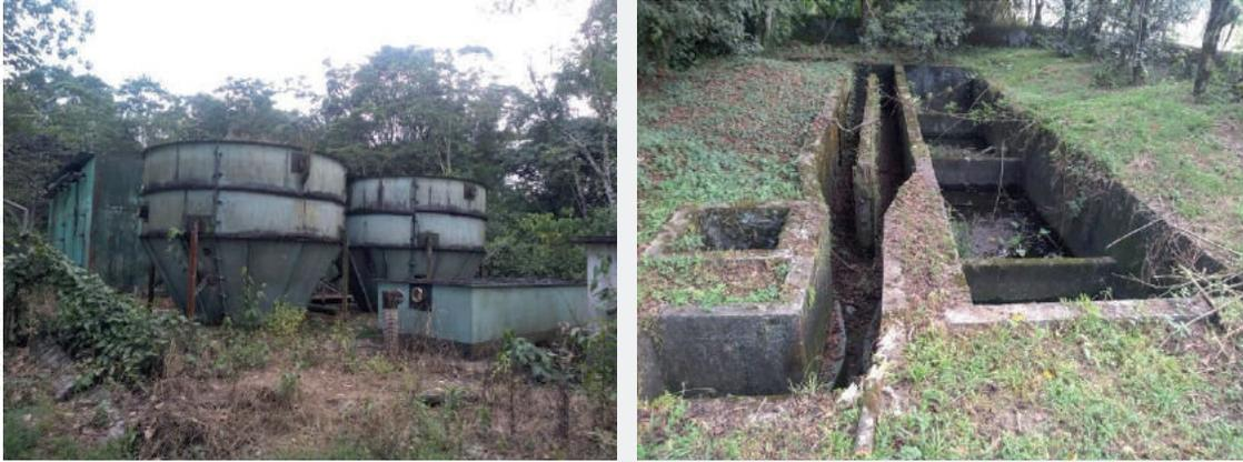
**Imagen 3.** Infraestructura de la PTAR del casco urbano de La Hormiga, en condiciones de deterioro a causa de su abandono.
