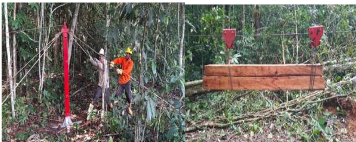
Figura 8 Instalación y operación del cable aéreo de mediana altura en NDFyB Los Puertos, Calamar
