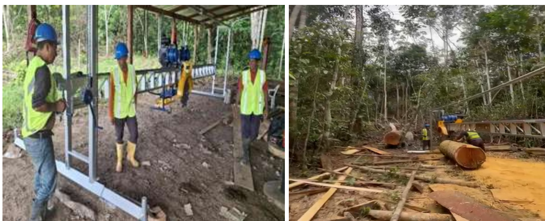
Figura 9 Instalación y operación del aserrío portátil Vectron 3530
